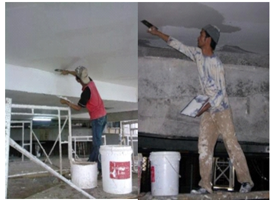
Gambar 1. Pekerjaan Skim Coat (sebelum Perbaikan)
