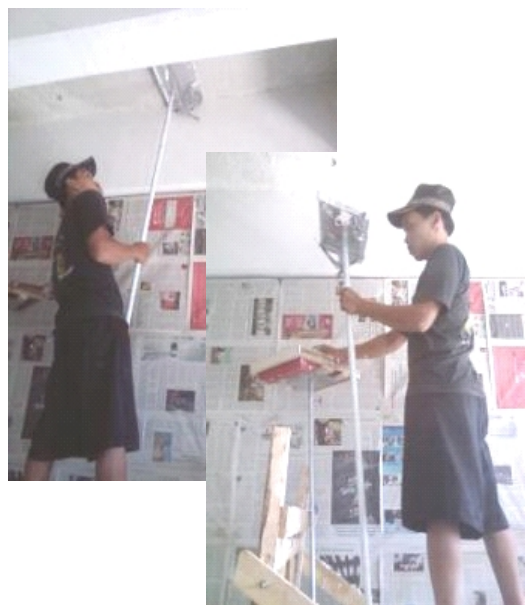
Gambar 3. Pekerjaan Skim Coat (dengan alat baru)
